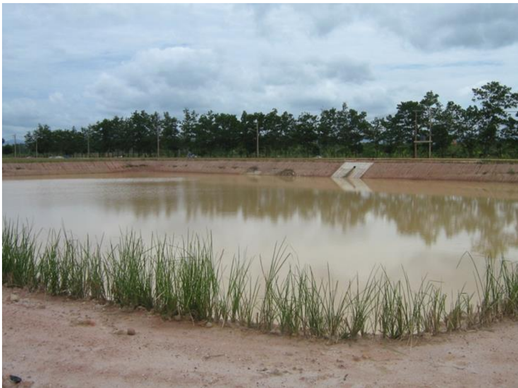
กิจกรรมขุดสระเก็บน้ำ ความจุ 30,500 ลูกบาศก์เมตร
