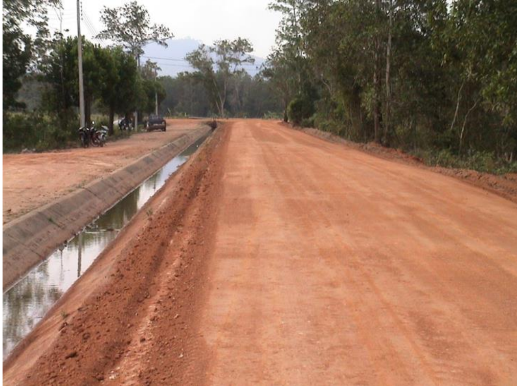
งานปรับปรุงถนนภายในโครงการ ความยาวประมาณ 10,000 เมตร
